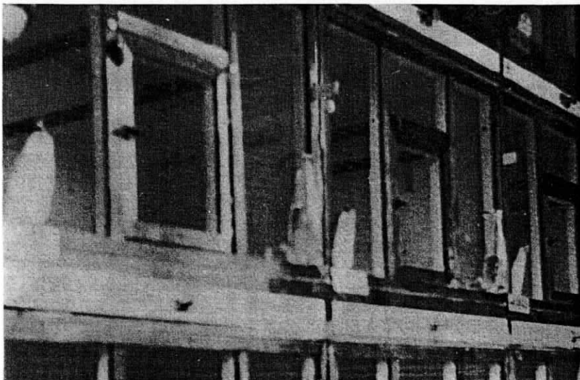
Fig. 19 - Particolare delle batterie di Oudermans.
